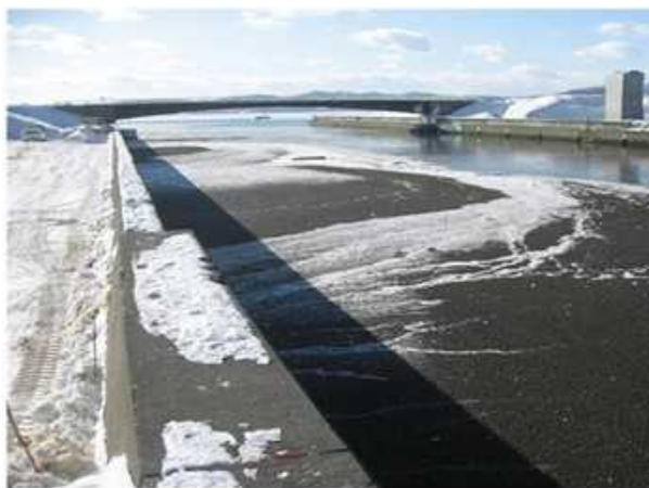
写真-2 第2湖口 航路埋塞状況 (H24. 1)
