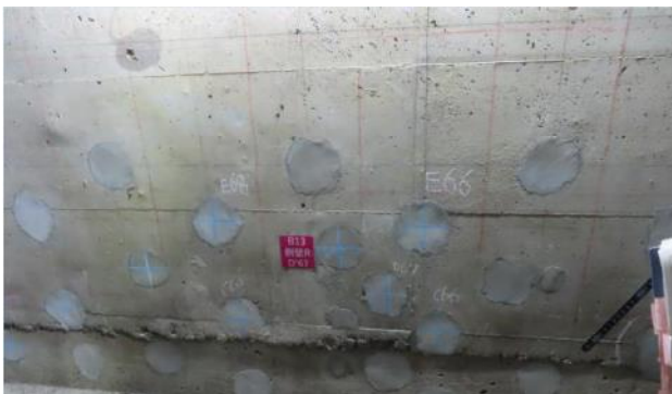
図-10 断面修復後の側壁
