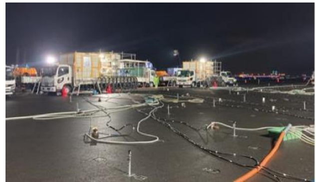
図-11 液状化対策工事(浸透固化剤注入)の様子
