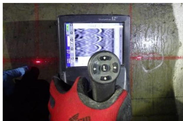
図-8 鉄筋探査の様子
