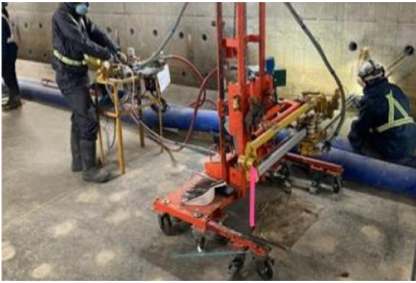
図-9 側壁削孔の様子
