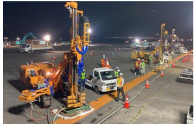
図-12 液状化対策工事(注入穴削孔)の様子
