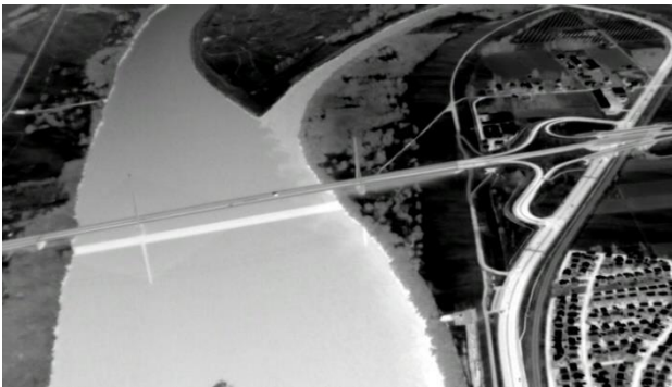
写真-7 郊外部（江別市美原大橋）
