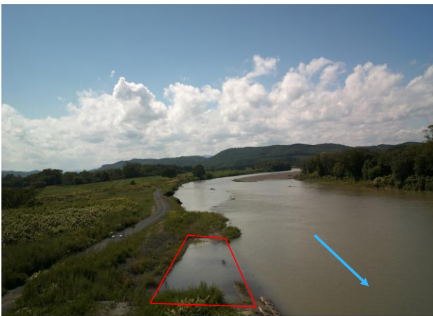
図-5 出水時の冠水している様子
