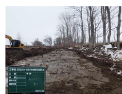
①移植地の表土すきとり
