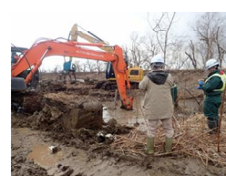
④移植対象木の掘り取り
