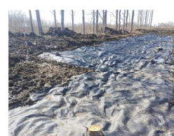
⑦移植地の防草シート敷設
