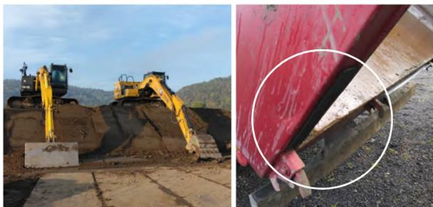
図-13 施工時の配慮事例（左：作業終了時のアームを下げた静置状況、右：ダンプアオリ板へのゴムラバーの設置）
