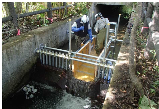
写真-1 人力での誘導水路設置状況
