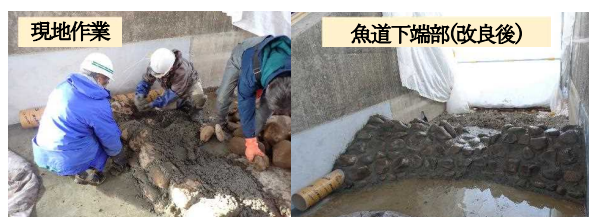
図-6 魚道下端部の改良実施状況
