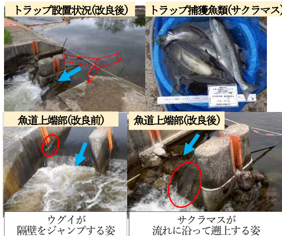
図-9 魚道上端部の改良前後の流れ状況とトラップ調査実施状況
