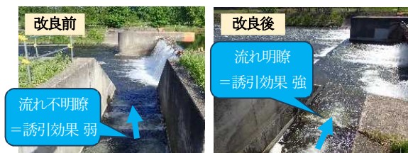
図-8 魚道下端部の改良前後の流れ状況
