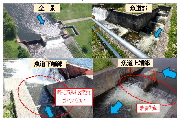
図4 西幹線頭首工の状況(改良前)
