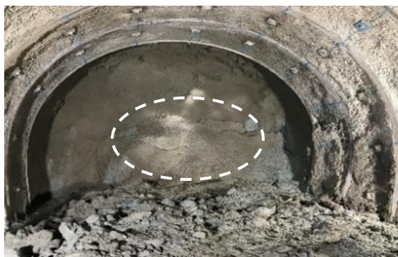
写真-1 鏡面の押出し
