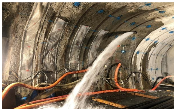
写真-6 TD=2,300m 多量湧水(3t/min)
