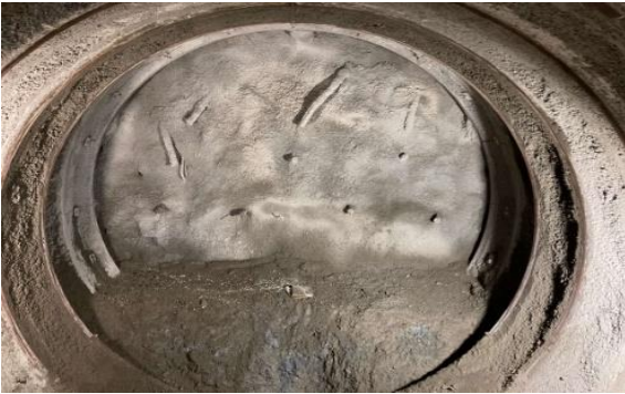
写真-11 円形二重支保施工状況
