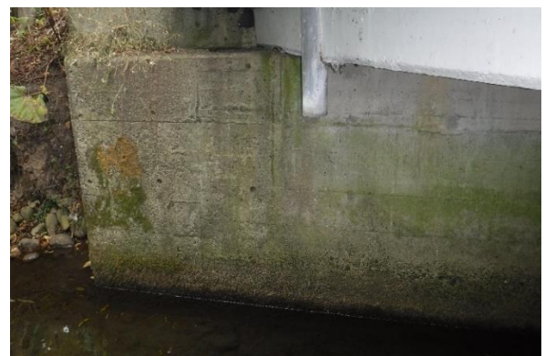
写真-6 ASRによるクラックは確認出来ない (ASRの可能性は低い)
