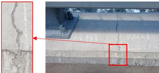
図-1 0.1mm のひび割れからのスケーリング発生例
