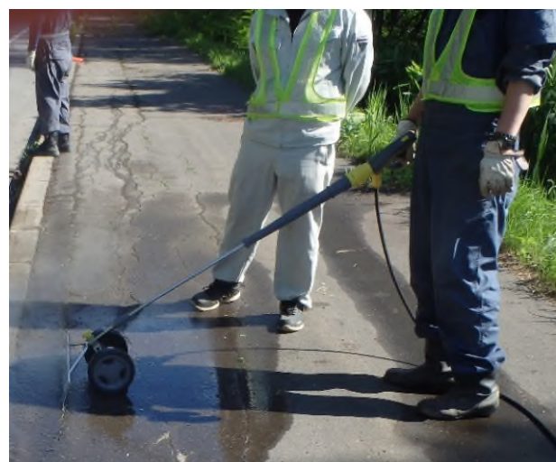
写真-4 熱水散布状況
