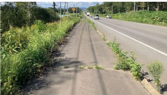
写真-7 熱水散布1回の箇所
