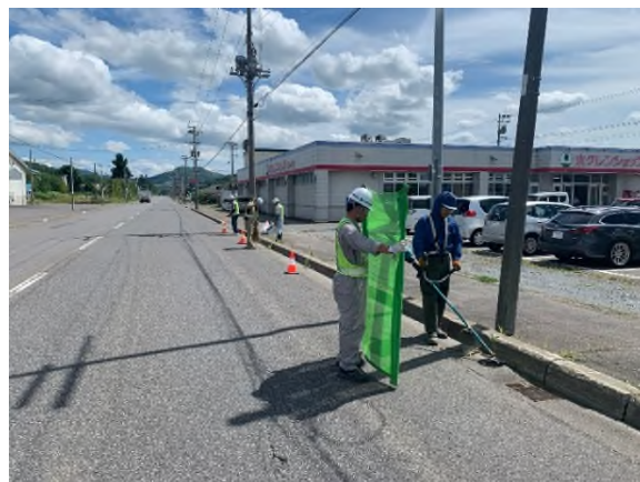
写真-1 肩掛け機械による人力除草作業
