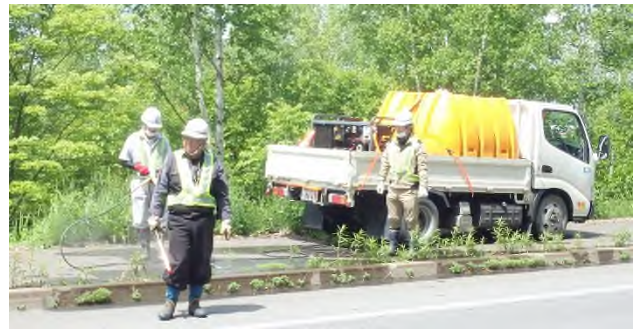
写真-13 熱水散布の作業状況
