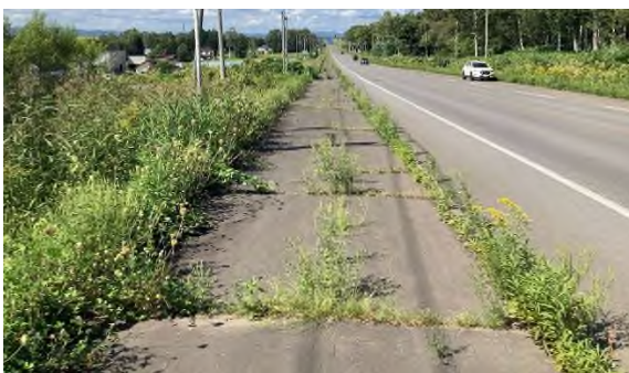
写真-6 従来除草（肩掛け式による人力除草）箇所
