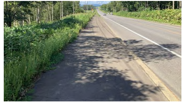
写真-9 熱水散布3回の箇所
