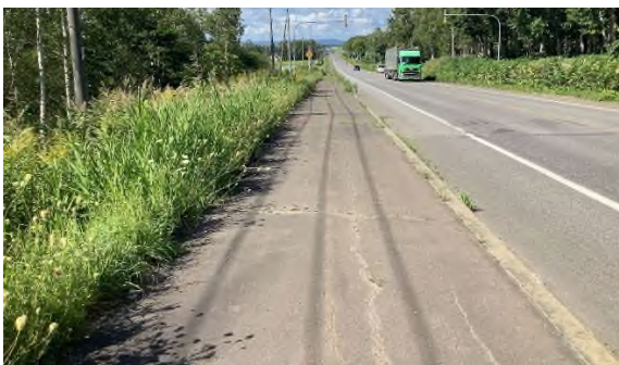
写真-8 熱水散布2回の箇所
