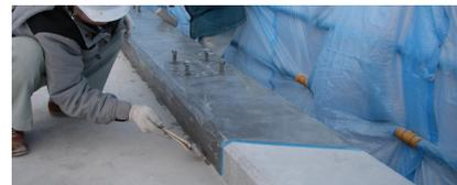
写真-1 道路橋地覆でのシラン系表面含浸材の塗布作業の例
