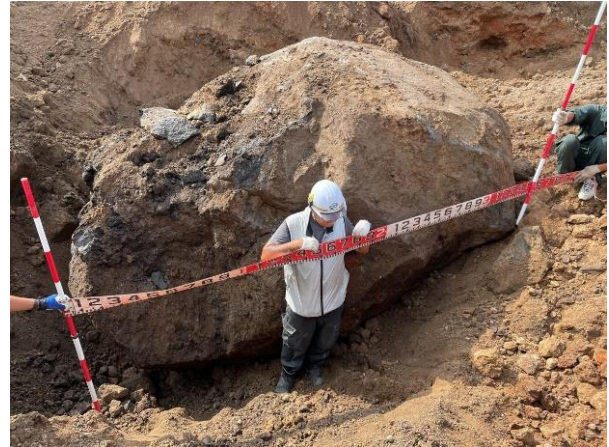
写真-1 基盤造成作業中に出現した巨岩
