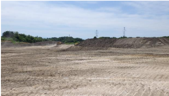
写真-4 上館山地域ほ場の基盤掘削状況
