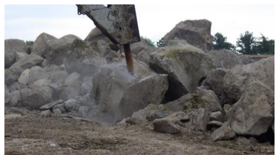
写真-5 ブレイカーによる巨岩の破碎
