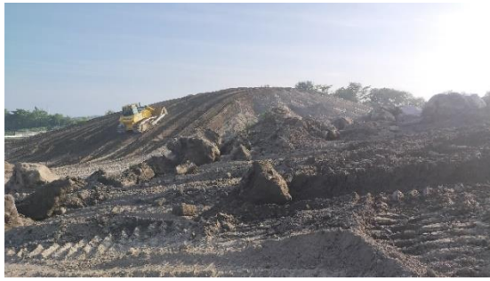
写真-3 大平地域ほ場の基盤掘削状況
