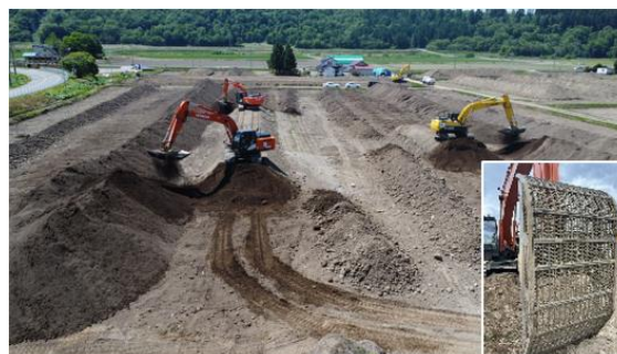
図-4 除礫状況とストーンローダのアタッチメント
