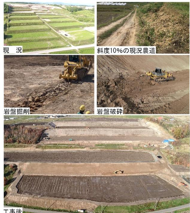
図-2 傾斜地での区画整理工事
