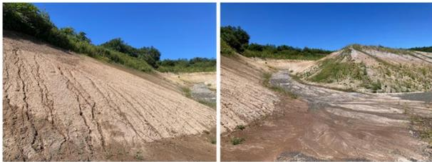
図-4 ガリ浸食を受け土砂が流出した法面
