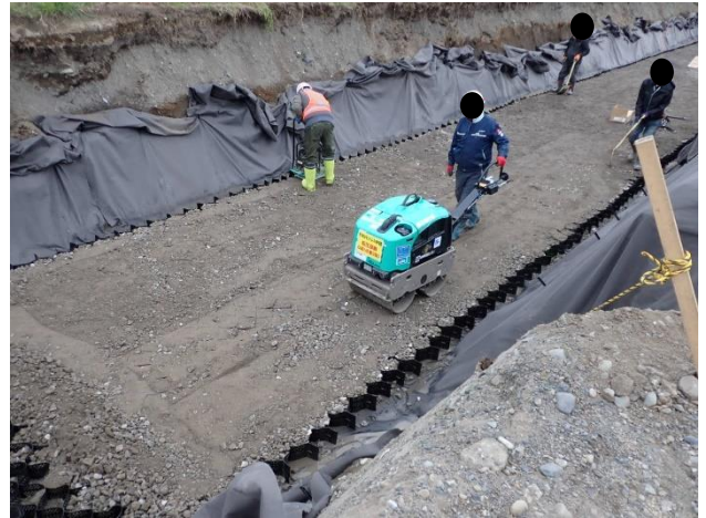
写真-5 ④下段中詰材転圧
