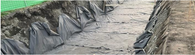
写真-2 ①吸出し防止材設置
