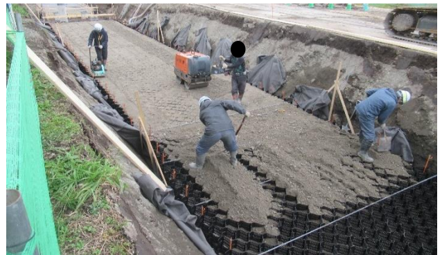
写真-7 ⑥上段中詰材敷均し・転圧
