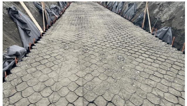
写真-8 ⑦上段ジオセルマットレス中詰材完了
