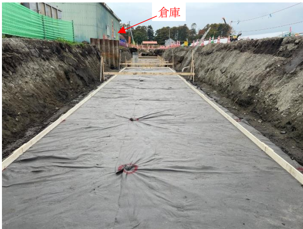
写真-9 ⑧ジオセルマットレス設置完了
