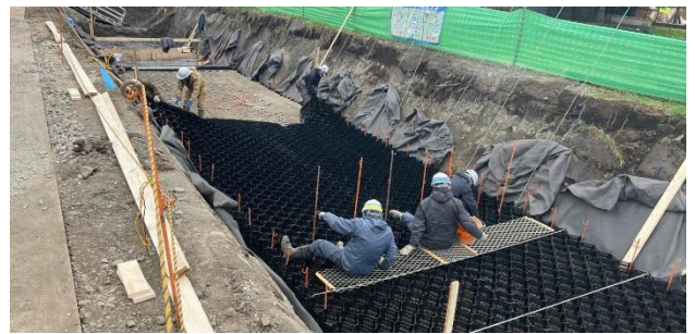
写真-6 ⑤上段ジオセルマットレス設置
