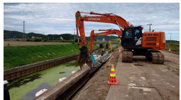
写真-8 笠コンクリート取壊し状況
