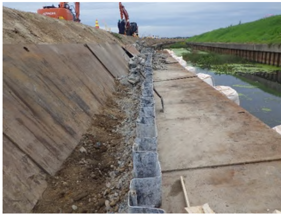
写真-9 笠コンクリート撤去後
