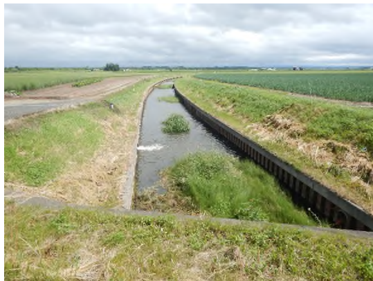
写真-1 現況排水路全景
