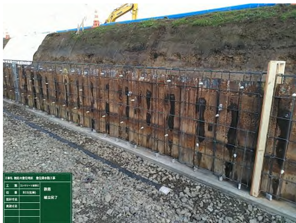
写真-10 コンクリート被覆工 鉄筋組立完了
