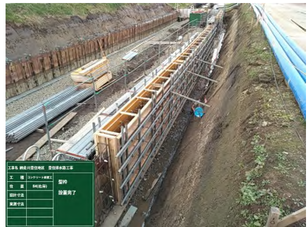
写真-11 コンクリート被覆工 型枠設置完了
