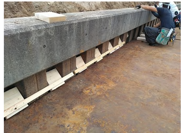
写真-7 笠コンクリート取壊し前準備状況
