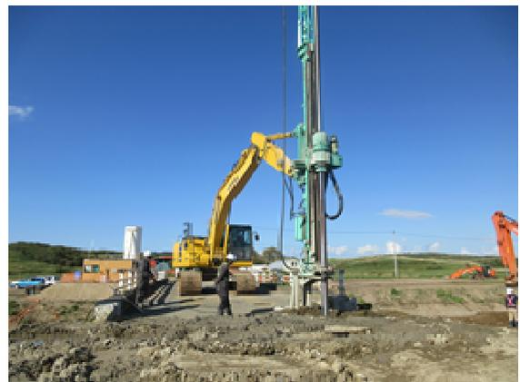
写真-2 MITS工法施工状況
