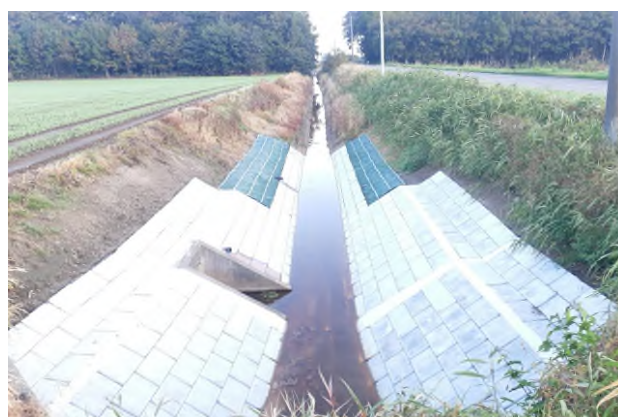
写真-12 西1線排水路（整備後）
