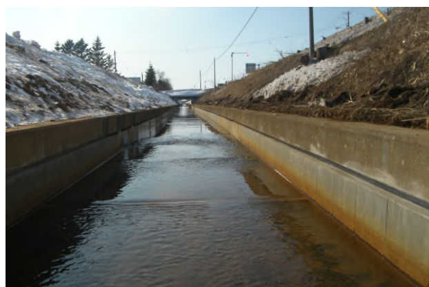
写真-10 南3号排水路（整備後）
