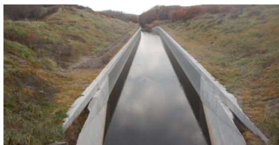
写真-6 トーツール沼切替排水路（整備後）
