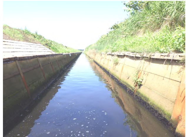
写真-14 南1号排水路（整備後）
