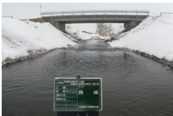
写真-8 宇遠別川切替排水路（整備後）
