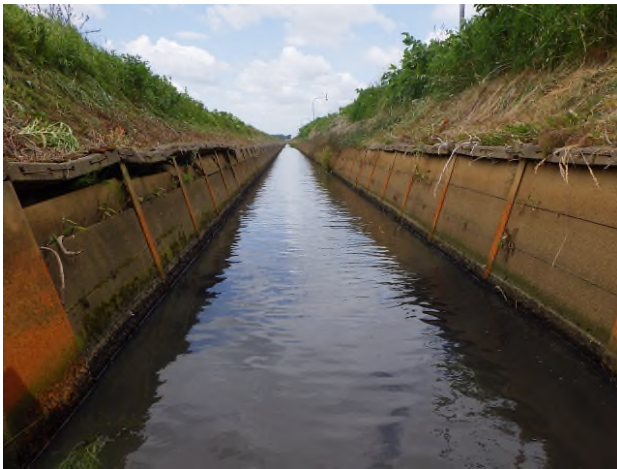
写真-13 南1号排水路（整備前）
