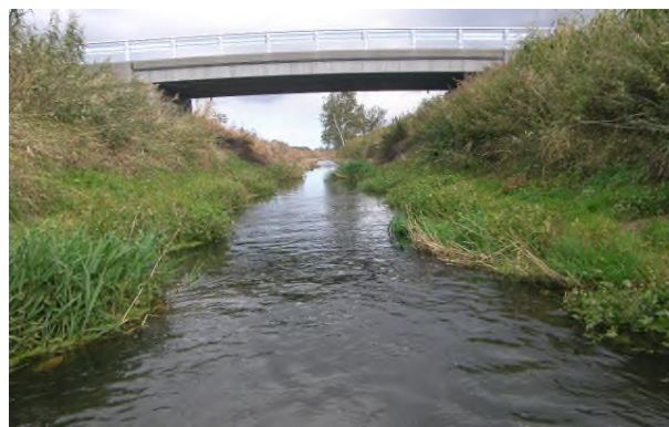
写真-7 宇遠別川切替排水路（整備前）
