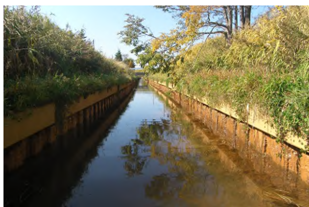
写真-9 南3号排水路（整備前）
