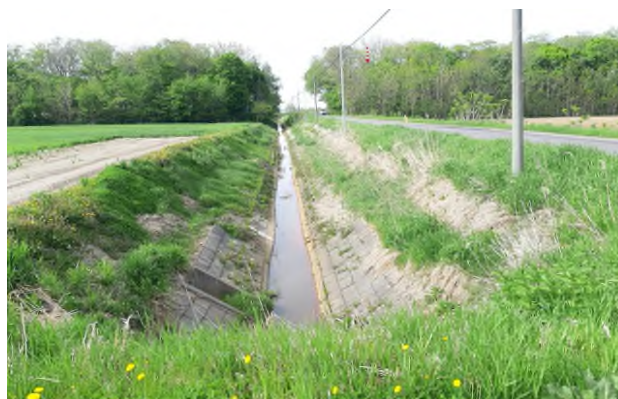
写真-11 西1線排水路（整備前）
