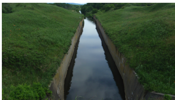
写真-5 トーツール沼切替排水路（整備前）
