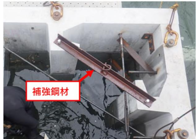
写真-4 補強鋼材
