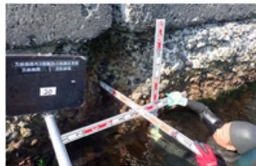
写真-2 北防波堤の老朽化状況
