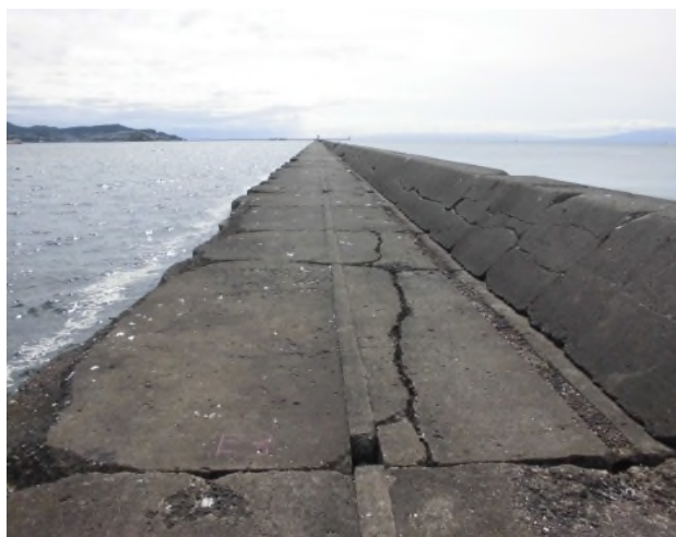
写真-2 北外防波堤上部工の劣化状況
