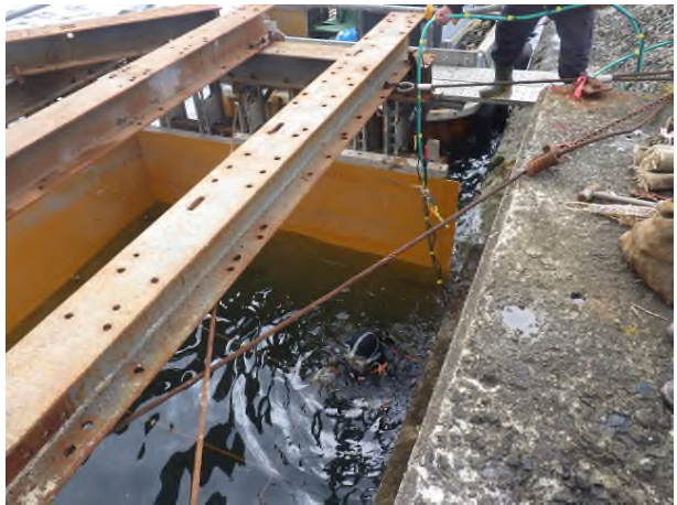
写真-7 鋼製型枠内の潜水作業
