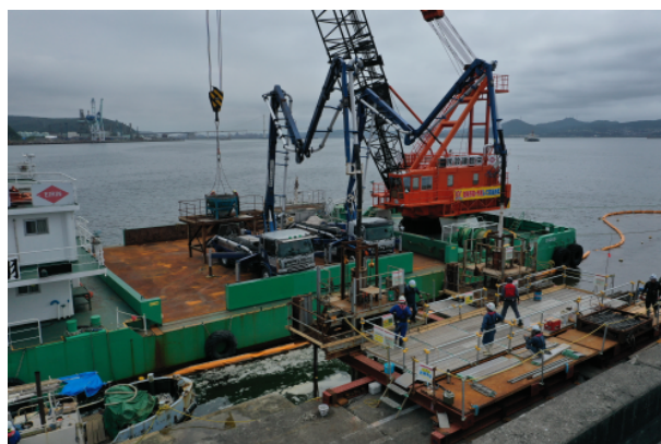
写真-8 水中コンクリート打設（プレキャスト型枠工法）
