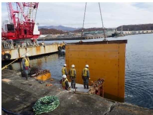
写真-4 鋼製型枠据付状況
