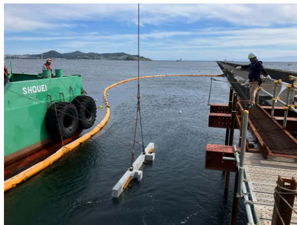
写真-5 プレキャスト型枠ブロック設置
