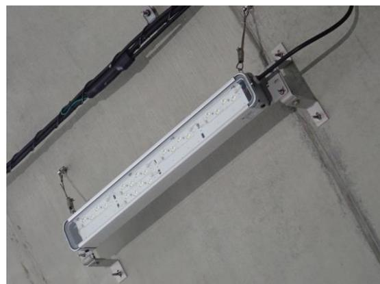
写真-2 直流給電方式用トンネルLED照明器具
