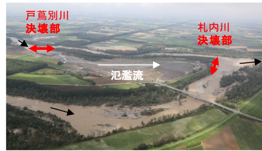
図-7 札内川・戸蔭別川合流点周辺の空中写真 (国土地理院撮影の空中写真 (2016年撮影) 13 (こ一部加筆)
