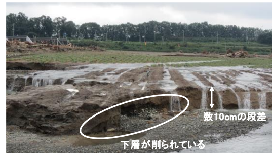
図-9 農地が残存していた箇所
