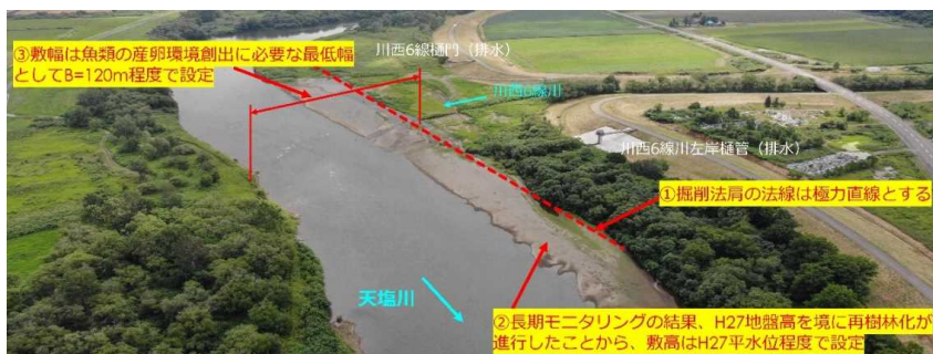
図-14 天塩川美深地区における河道掘削及び整正手法(川西6線樋門周辺)
