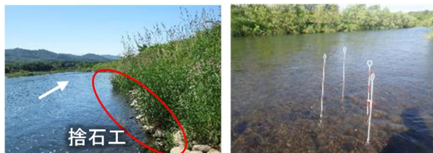
写真-2 河道掘削後の状況（KP23.8付近）
