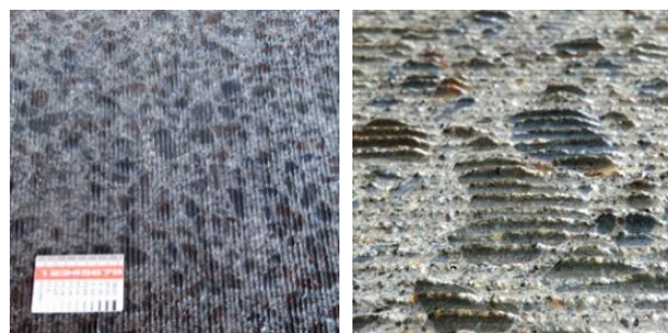
写真-1 ダイヤモンドカッタによる表面研削の仕上がり路面とフィン（背びれ）状の凹凸の例
