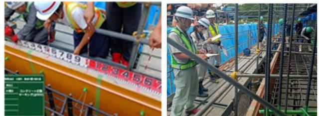
パイブレーター挿入間隔マーキング 施工状況把握チェック状況
