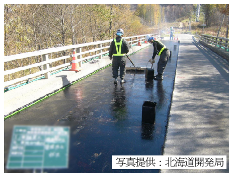
写真-1 床版防水層の設置状況
