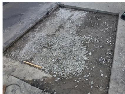
写真-1 床版上面に発生する土砂化
