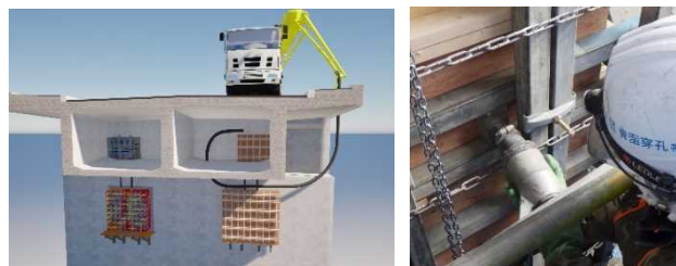
写真-4 コンクリート打設状況
