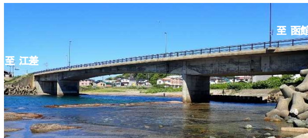
写真-1 松城橋の現況写真（海側より撮影）
