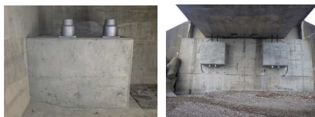
写真-5 負反力対策工の完成状況
