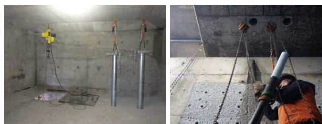
写真-3 負反力対策工の材料搬入状況
