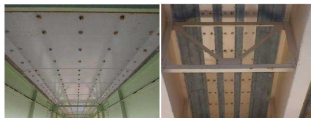
写真-1 鋼板接着補強の例 2)
