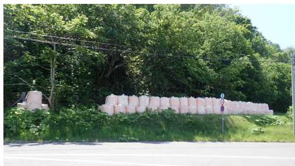
(b) 大型土のう 2段積み
