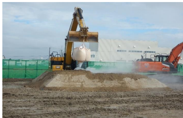
写真-7 固化材散布
