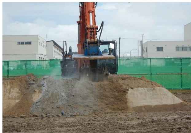
写真-8 攪拌の様子
