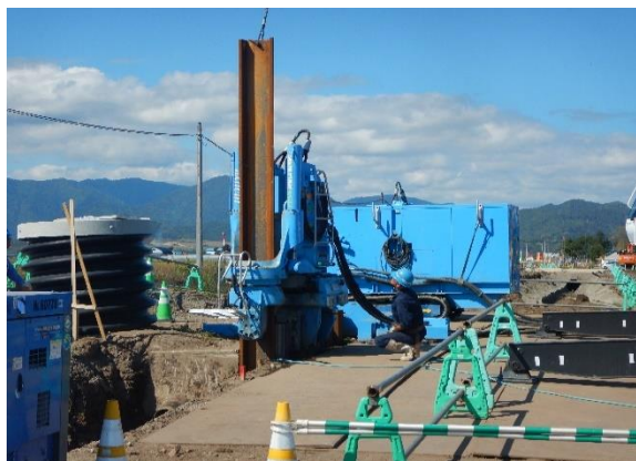
写真-4 圧入工法による打込み
