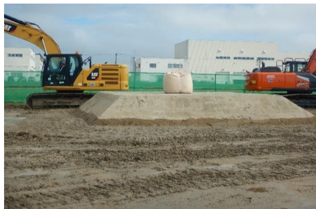
写真-6 盛土整形
