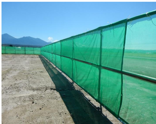
写真-5 飛散防止対策(防塵ネット)
