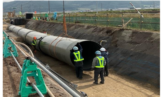
写真-3 管の布設状況
