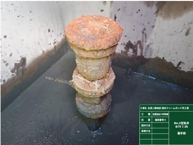
写真-1 経年劣化により発錆した弁類
