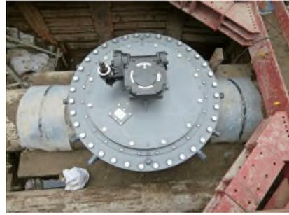
写真-6 インサー切替弁の例 (メーカーホームページより)
