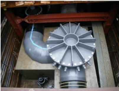
写真-5 インサープラグ分岐型の例 (メーカーホームページより)
