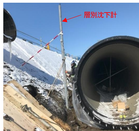
図-10 層別沈下計設置状況（篠津運河中流地区）
