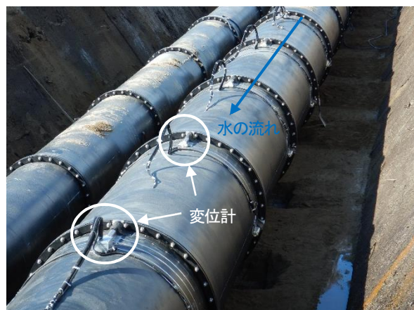
図-6 変位計の設置状況
