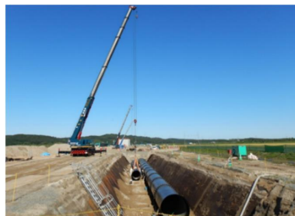
図-1 管水路の施工状況（勇払東部地区）
