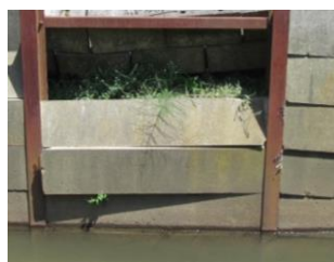
【柵板の損傷】
