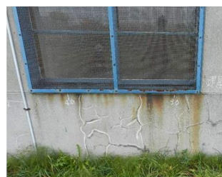
【建屋：コンクリートのひび割れ】
