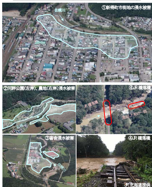
写真-2 佐幌川周辺被災状況
