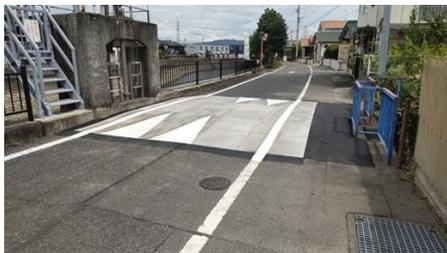
写真-3 佐賀県佐賀市で施工されたPCaCo製ハンプの出来形
