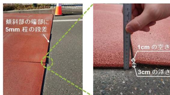
図-1 北海道におけるG製ハンプのゴム部材の温度収縮（例）
