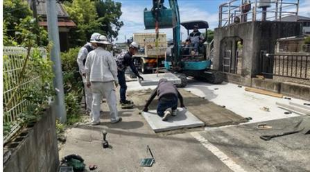
写真-2 佐賀県佐賀市におけるPCaCoハンプの施工状況
