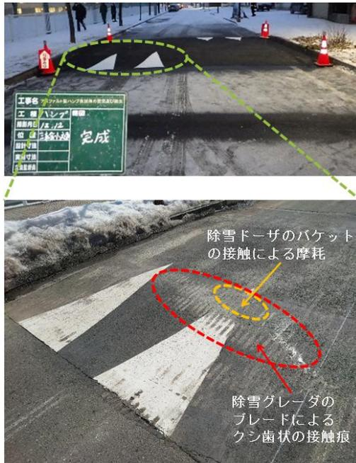
図-2 北海道におけるAs製ハンプの損傷の程度(例)
