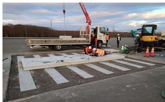
写真4 PCaCo製ハンプ供試体の施工状況
