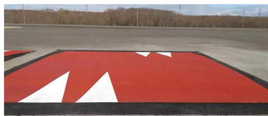
写真5 PCaCo製ハンプ供試体の完成形
