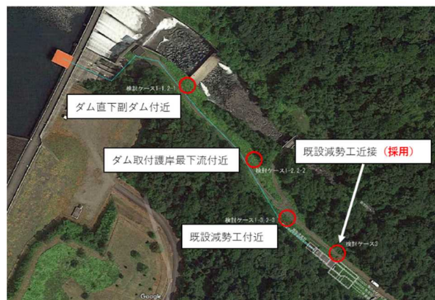
写真-2 小水力発電施設 検討位置
