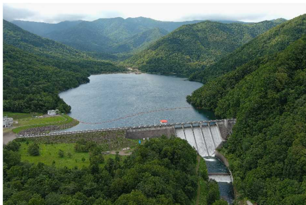
写真-1 美生ダム
