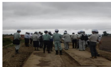
写真-1 工事現場見学会の様子
