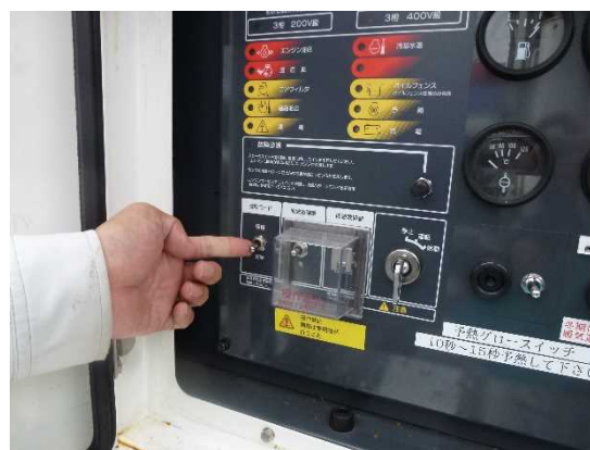
写真-5 開建職員による排水ポンプ車巡視状況
