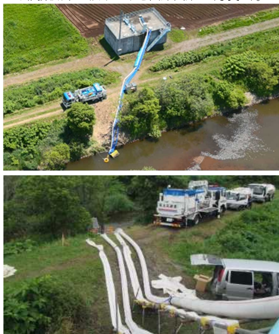
写真-2 災害水排水ポンプ車設置及び給水状況
