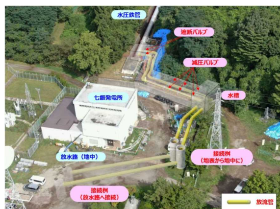
図-9 かんがい放流設備復旧イメージ図 2)
