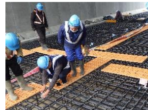
写真-12 底版配筋状況
