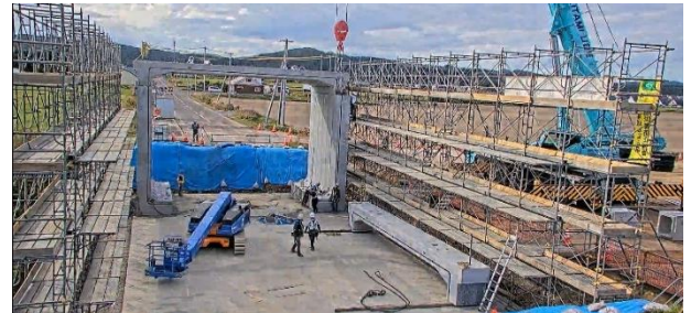
写真-2 R側側壁施工状況（6スパン目）
