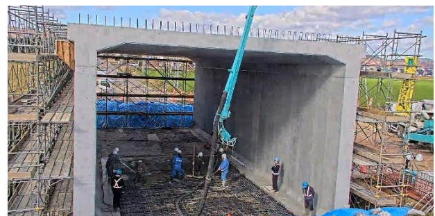
写真-14 底版施工状況
