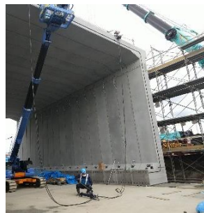
写真-7 頂版部材連結状況
