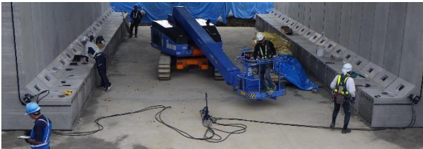
写真-5 側壁部材連結状況
