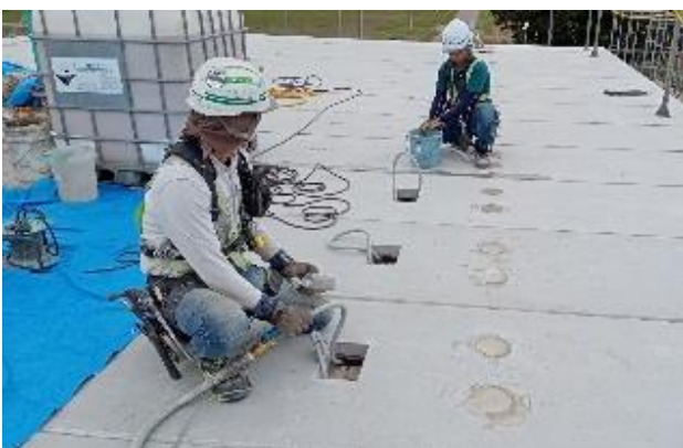
写真-9 頂版グラウト注入状況
