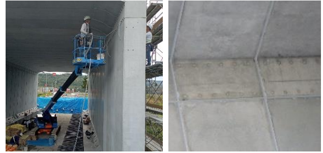
写真-10, 11 側壁・頂版連結 モルタル注入状況
