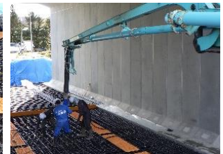
写真-13 底版施工状況
