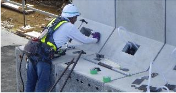
写真-4 側壁部材連結状況
