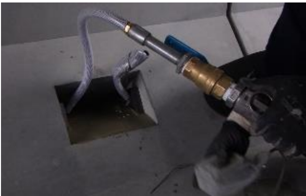
写真-8 側壁グラウト注入状況
