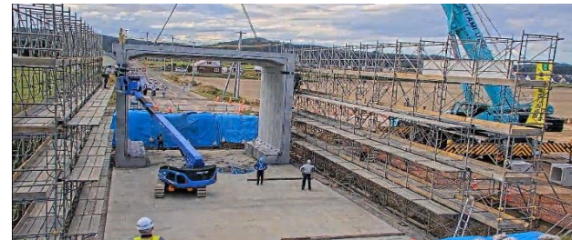
写真-3 頂版施工状況（6スパン目）
