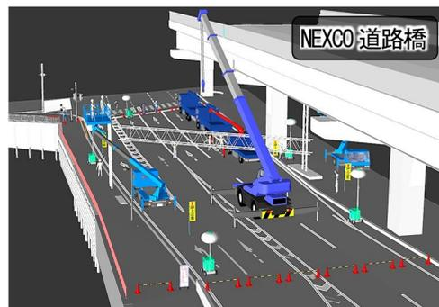
図-8 クレーン等工事用車両の配置計画(後方)
