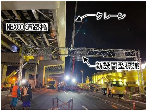
図-10 実際のクレーン等工事車両配置（前方）
