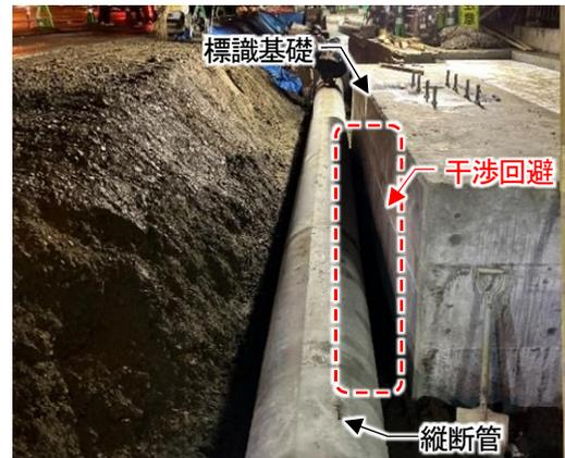
図-15 縦断管と新設標識基礎との干渉確認状況
