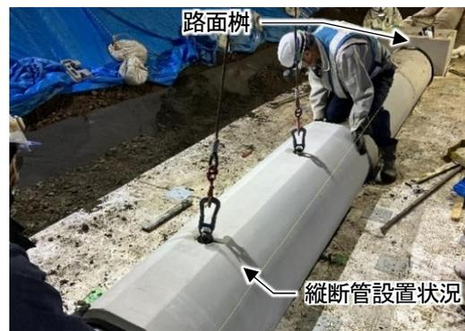
図-13 EPS上の縦断設置状況
