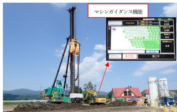
図-9 ICT地盤改良工の施工状況
