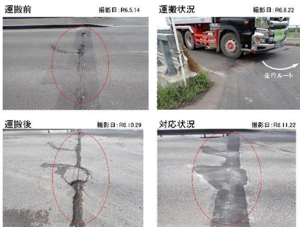
図-7 運搬路の汚損・破損状況調査結果
