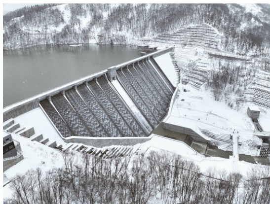
写真-1 新桂沢ダム試験湛水の様子
