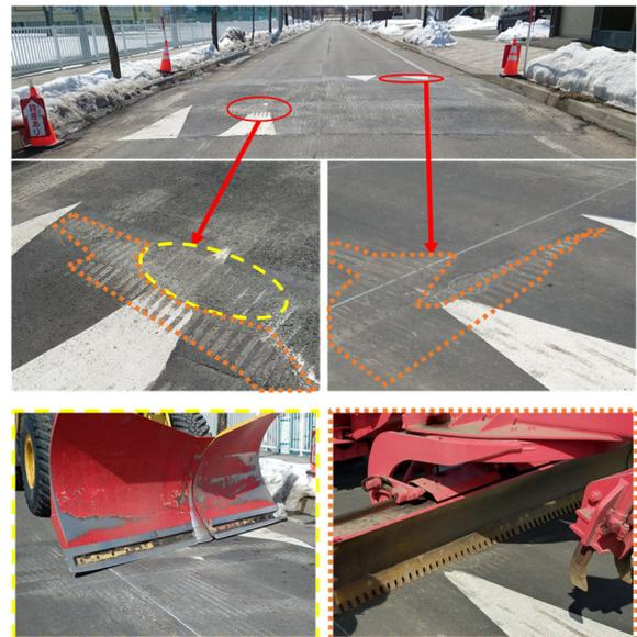
(a) 除雪ドーザによる摩耗 (b) 除雪グレーダーによる接触
