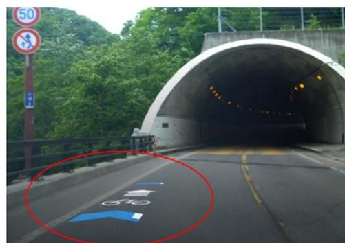
写真-1② トンネル入口手前の路面表示
