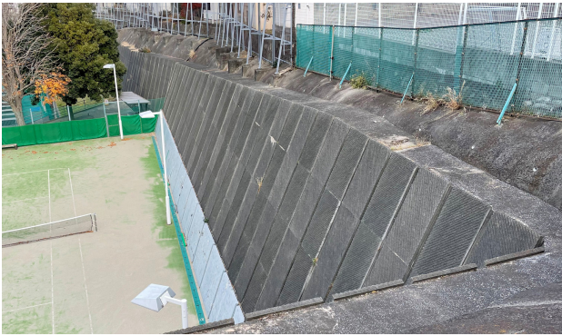
写真-8 45°ストライプによるテクスチャが交互に彫られた コンクリート擁壁面の眺めの例 (神奈川県横浜市) 2025年1月撮影
