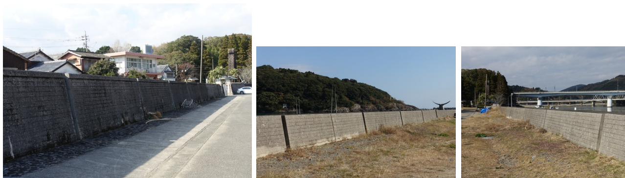
写真-6 耳川・美々津護岸(宮崎県日向市) 2024年12月撮影 左: 北面・全景、 中央: 南面・逆光方向からの眺め、 右: 南面・順光方向からの眺め
