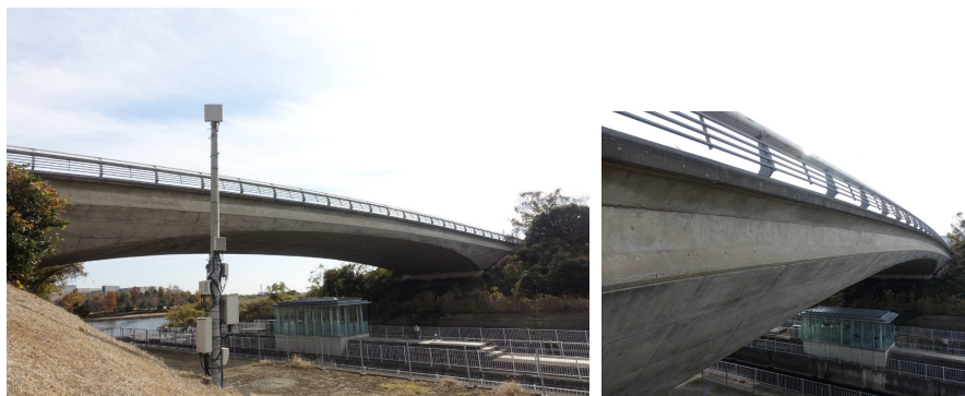
写真-5 ラグーナゲートブリッジ(愛知県蒲郡市) 2024年12月撮影 左: 側面全景、 右: 橋桁側面の立体形状と水切り
