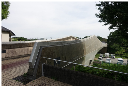
写真-3 鶴乃橋（東京都多摩市）2024年12月撮影 左：全景、 右：橋桁兼壁高欄側面の金属製水切り
