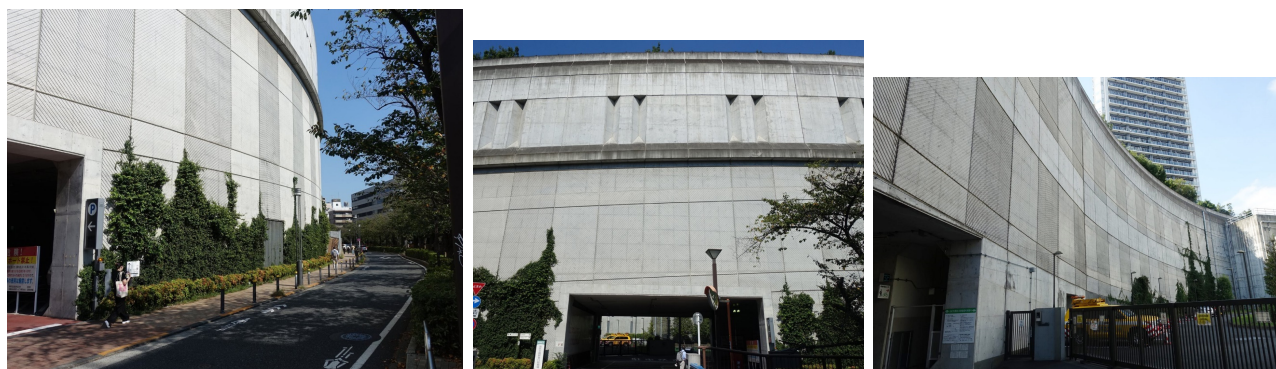
写真-7 首都高速道路 大橋ジャンクション（東京都大田区）2023年10月撮影 左：外周壁面・全景、中央：外周壁面の順光かつ正面からの眺め、右：内周壁面
