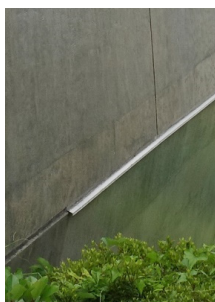
写真-3 鶴乃橋（東京都多摩市）2024年12月撮影 左：全景、 右：橋桁兼壁高欄側面の金属製水切り
